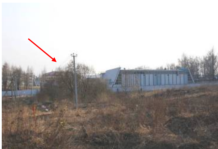
Rys. 9. Zerwane przewody linii energetycznej (punkt 7 rys. 2)
