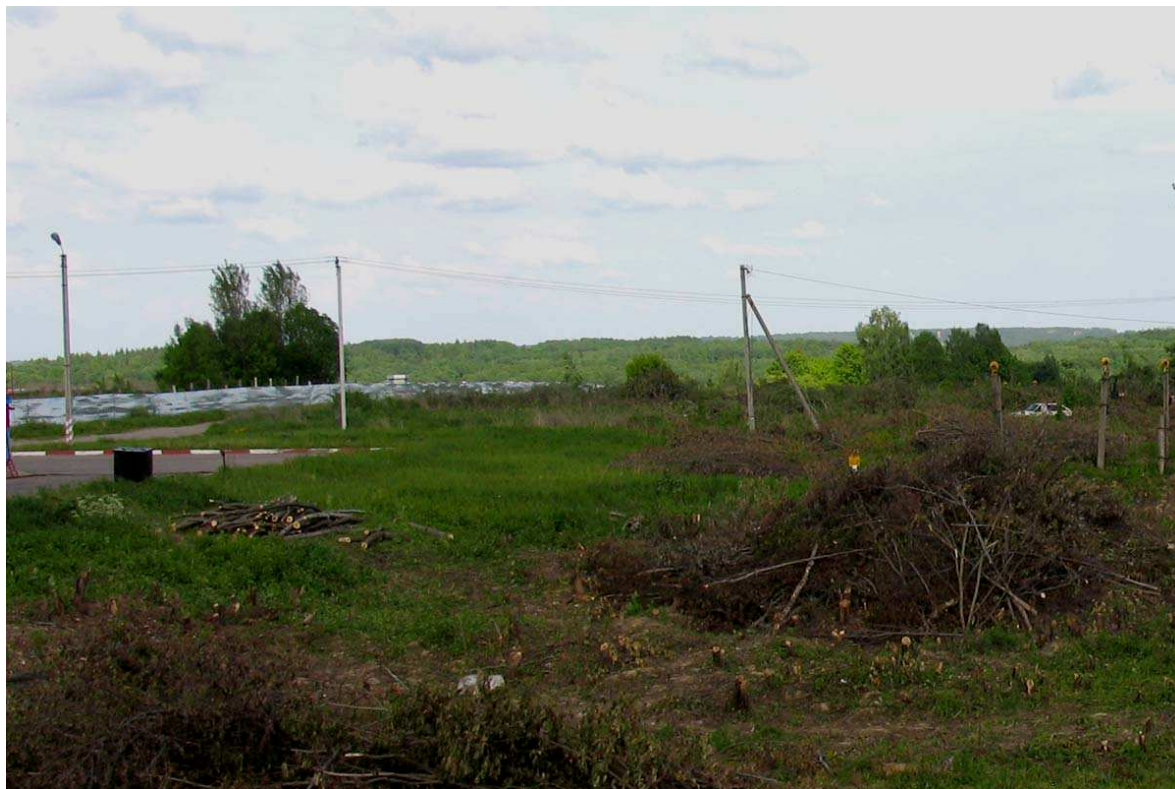
Wycięte drzewa i krzewy w osi podejścia w odległości ok.700 m od progu DS 26.
