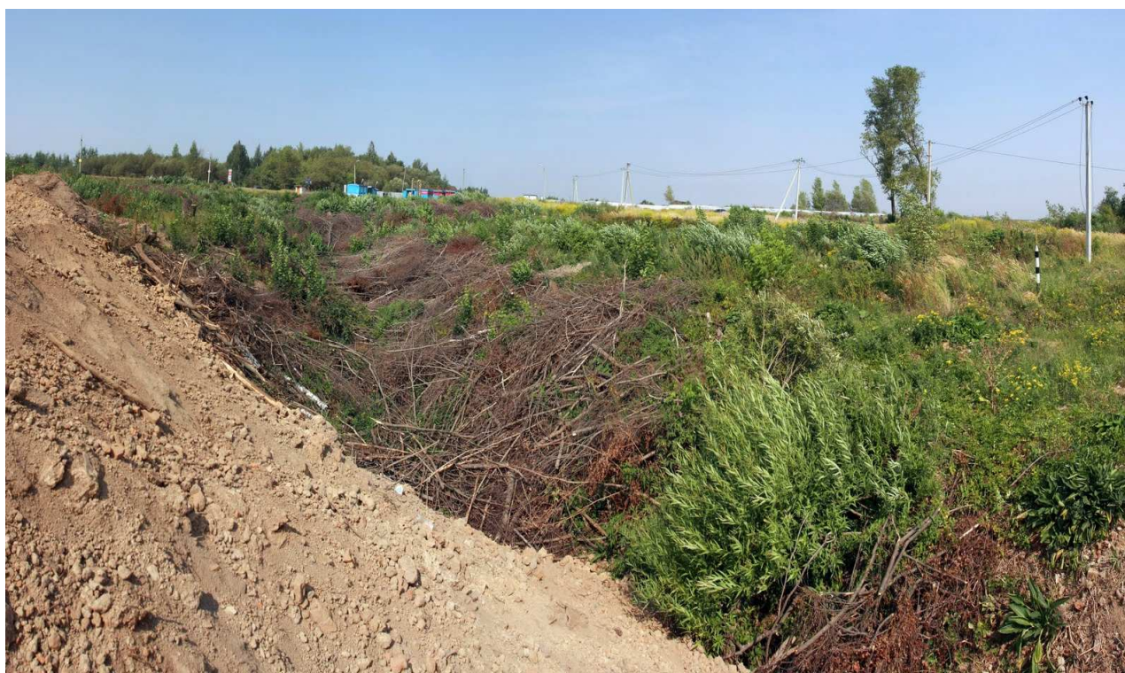
Wycięte drzewa i krzewy w osi podejścia w odległości ok.700 m od progu DS 26.
