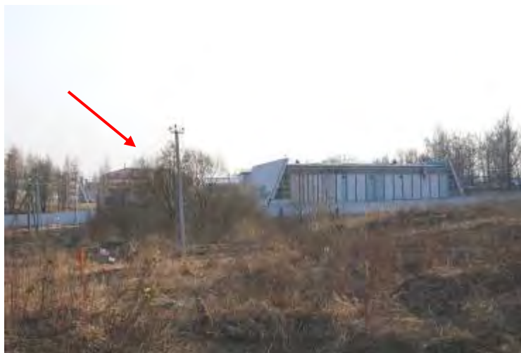
Rys. 9. Zerwane przewody linii energetycznej (pkt 7 rys. 2)
