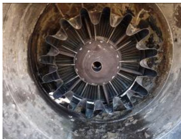
Zdj. 48. Widok ostatniego stopnia TNC i mieszalnika
