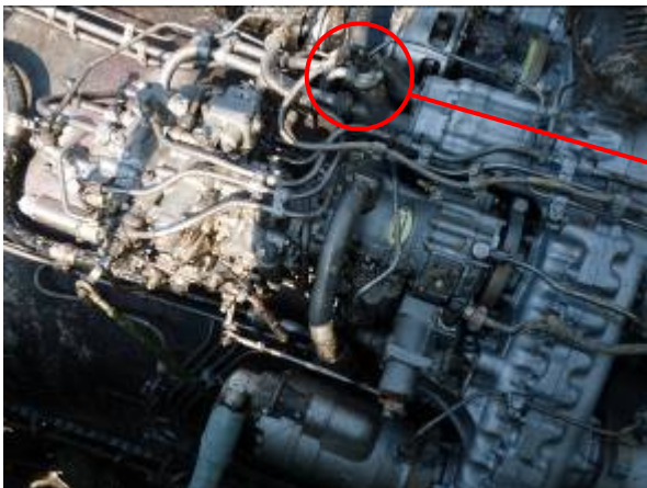
Zdj. 39. Widok agregatów silnikowych oraz elementów sterowania silnikiem
