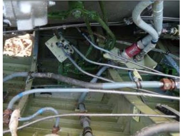
Zdj. 36. Widok elementów sterowania silnikiem
