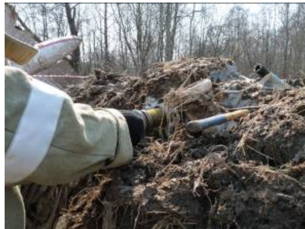
Zdj. 52. Demontaż i sprawdzenie filtra oleju MFS-30 z głównej pompy oleju OMN-30
