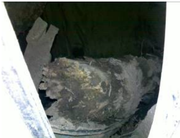
Zdj. 3. Widok fragmentu drzewa zalegającego we wlocie bezpośrednio przed AK I st. SNC
