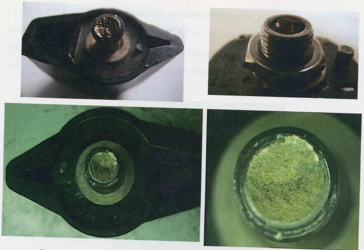
Рисунок № 2.17- Вид переключателя в месте его разрушения
